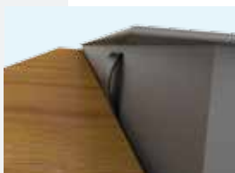
klemming via veerclips
